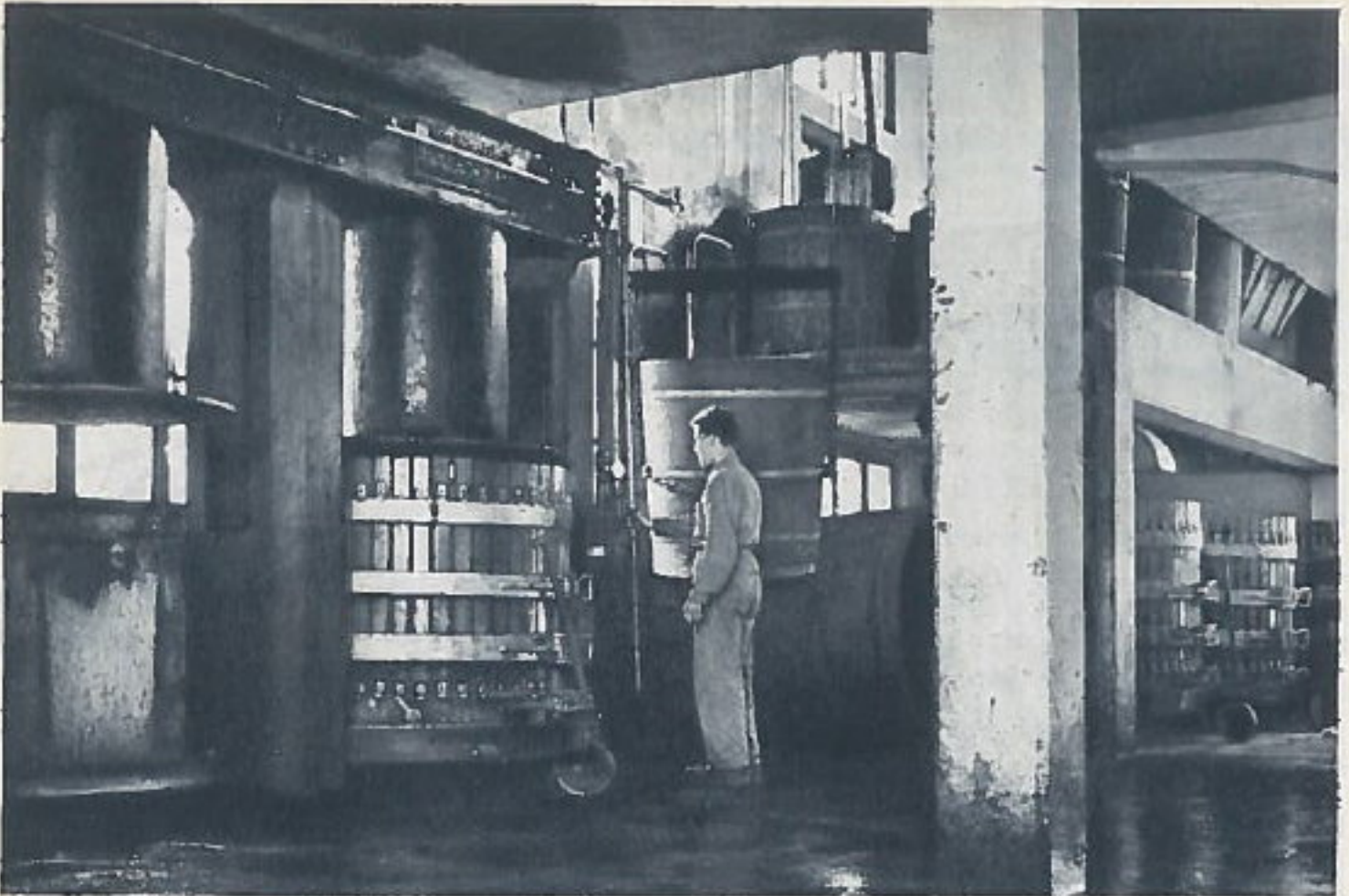
Blick in die neue Trotte. Man beachte die am Aufzug angehängte Traubenstände. Die meisten Rebbaupern haben diese Standentype angeschafft. Sie kann mittels Aufzug und Laufstoge vom Wagen aufgezogen, zur Traubenmühle gefahren und dort gelippt werden.
